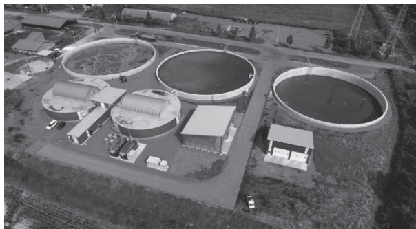
バイオガスプラント
