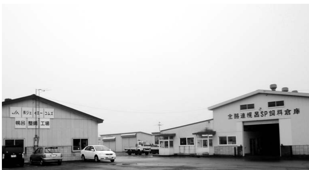
全酪連幌呂SP飼料倉庫
