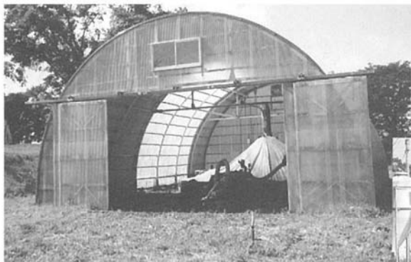
▲写真3 スラリー1次調整槽
