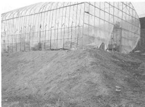
▲写真6 地下に埋められたガス発酵槽
